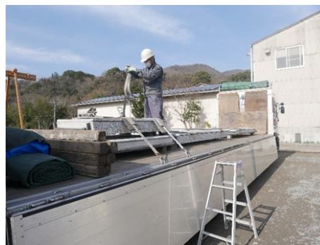
写真2 GRCの積み込み作業
