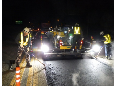
舗装補修工事
